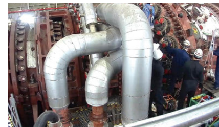
設備点検の様子
